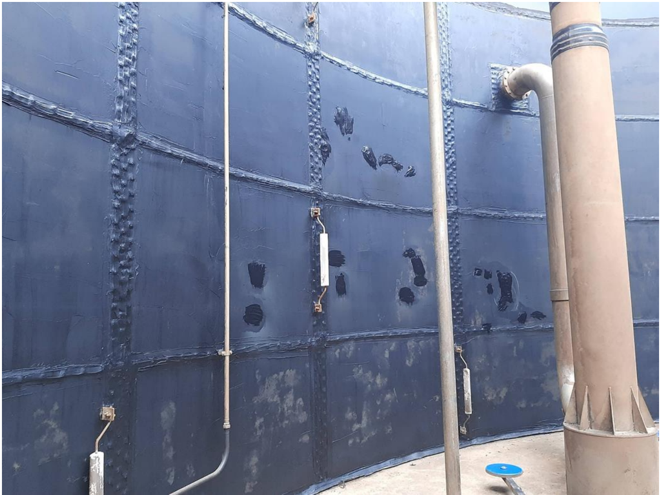
Gut sichtbar: die neu abgedeckten rostigen Stellen
