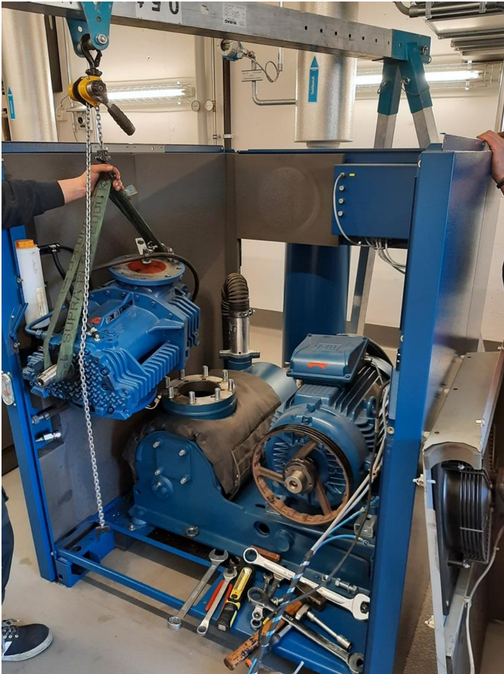
Einbau der Stufe
